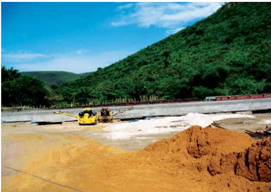
PAR : Préfabrication des poutres maîtresses en auge (béton armé) pour le pont Mai-Ndombe RN 1
